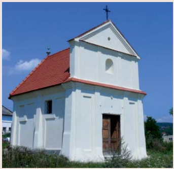
Kaplica dworska w Kobylanach, fot. A Kwarcik
