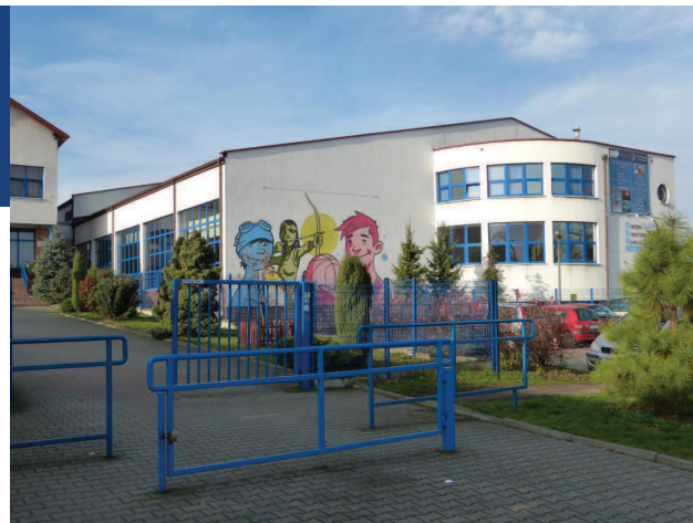
widok od ul. Kolejowej – stan istniejący
