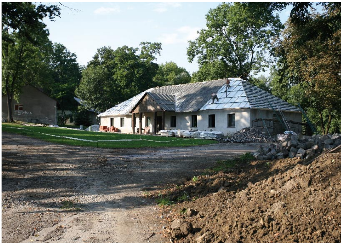
Dwór w Brzeziu w trakcie odbudowy, fot. T. Kalarus
