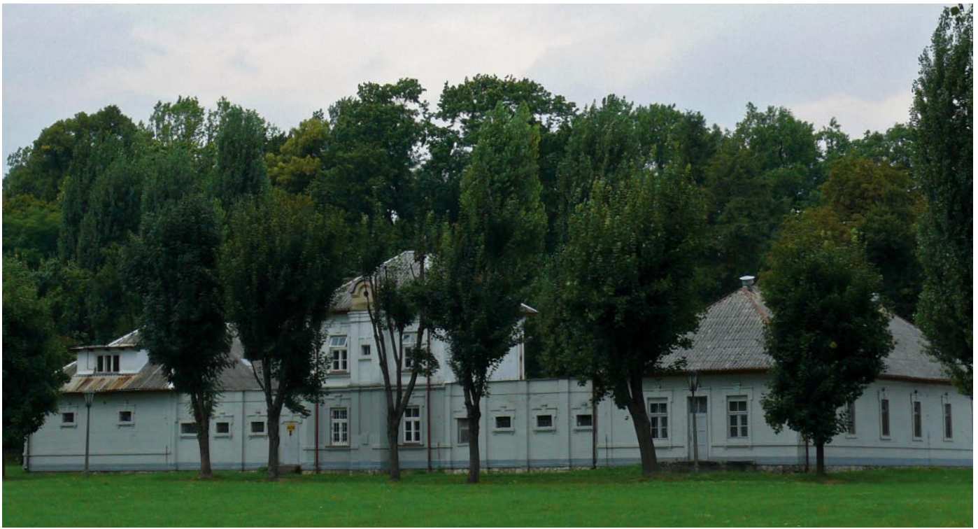
Zabudowania dworskie w Balicach, fot. A. Kwarciak
