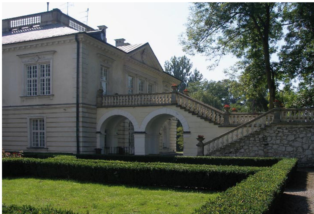
Pałac w Balicach od strony parku, fot. UG Zabierzów
