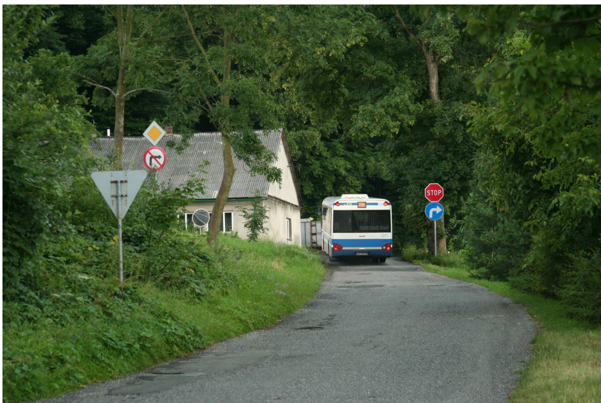
Rys. 9.9. Włączenie drogi wyjazdowej z przystanku autobusowego „Droga do Niegoszowic” do drogi krajowej numer 79 już dziś wymaga modernizacji. Widoczny na zdjęciu autobus linii 238 ledwo mieści się na dwukierunkowej jezdni.
