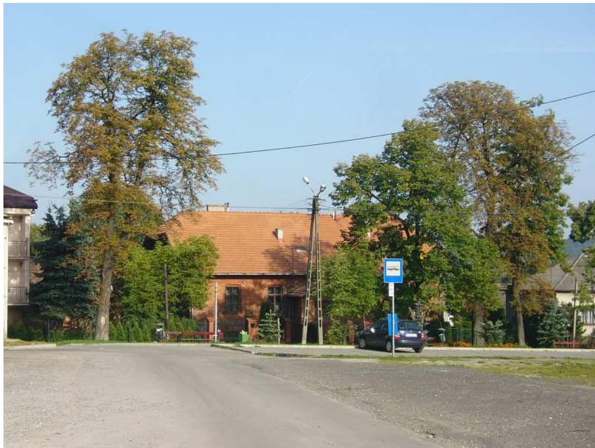
Rys. 9.4. Obecny wygląd przystanku autobusowego „Rudawa Kościół” - jednocześnie propozycja lokalizacji punktu przesiadkowego dla autobusów w Rudawie.
