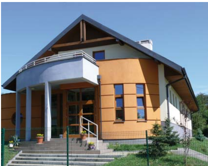
Dom ludowy w Burowie, fot. A. Kwarciak
