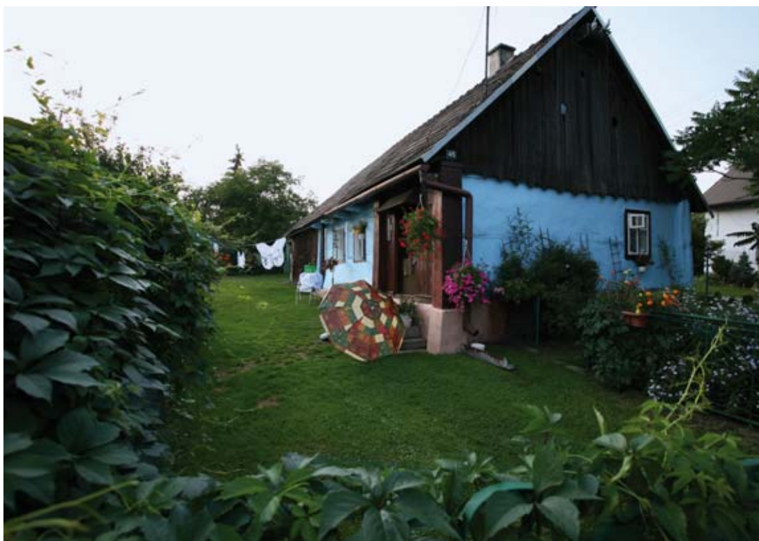
Chałupa drewniana, zrębowa w Brzeziu z ok. 1908 r., fot. T. Kalarus
